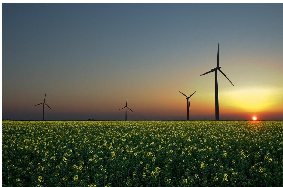
Fig. 1 – Exemple de turbine eoliene în Germania [1]
